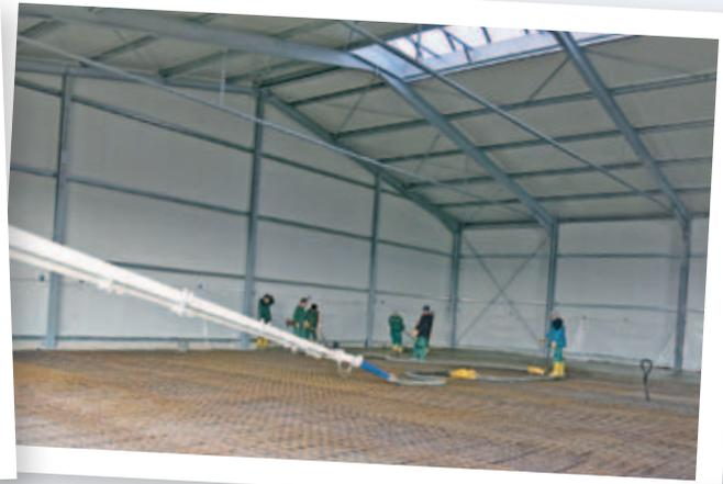
fertig. Im April wurde der durch massive Eisengeflechte verstärkte Beton-Hallenboden gegossen, der danach 4 Wochen aushärten musste.
